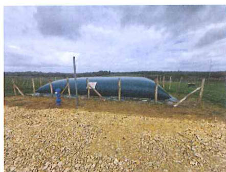
Installation clôture bâche incendie
