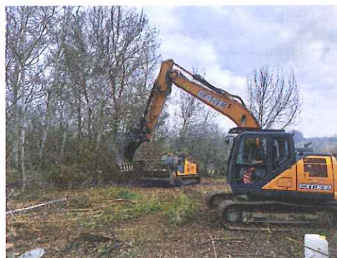
Nettoyage immeuble « Cheval Blanc »
